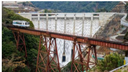
阿蘇立野ダムの状況(令和6年2月) (下流側より望む)
